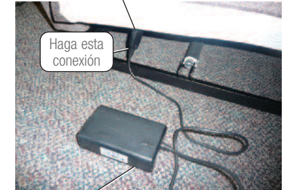
Transformador de corriente
